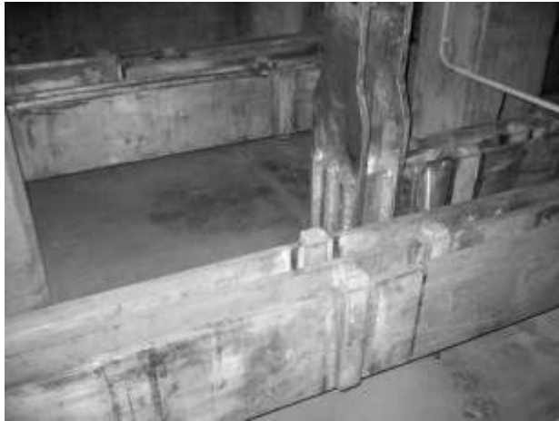
Beispiel einer Cadweld-Verbindung an Aluminium-Schienen 300 x 25 mm
